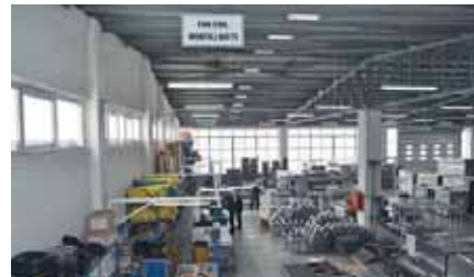
Fan Coil Montaj Hattı
